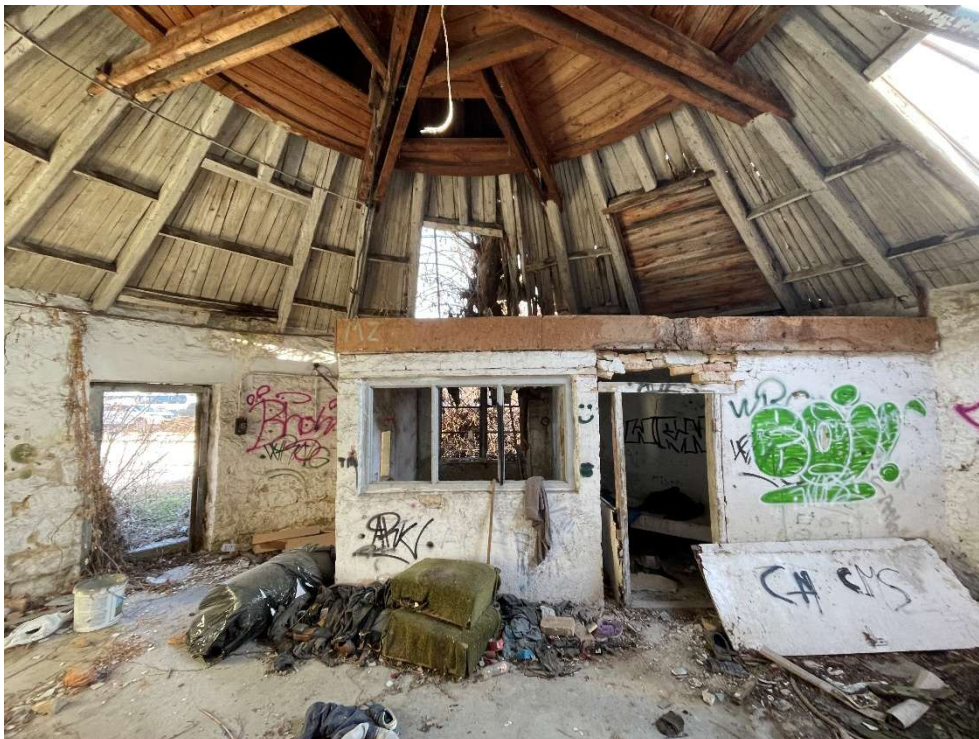
8. Az épületbelső dél felé nézve, 2025.
