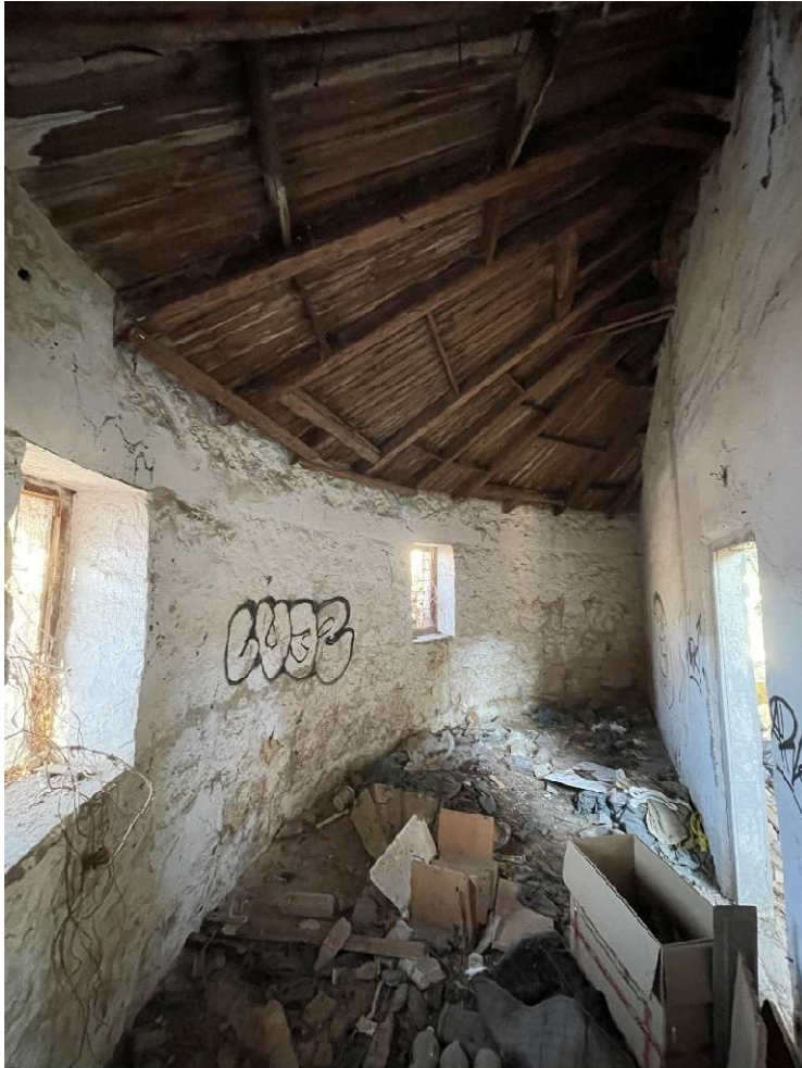
11. Az épületbelső, északi oldal
